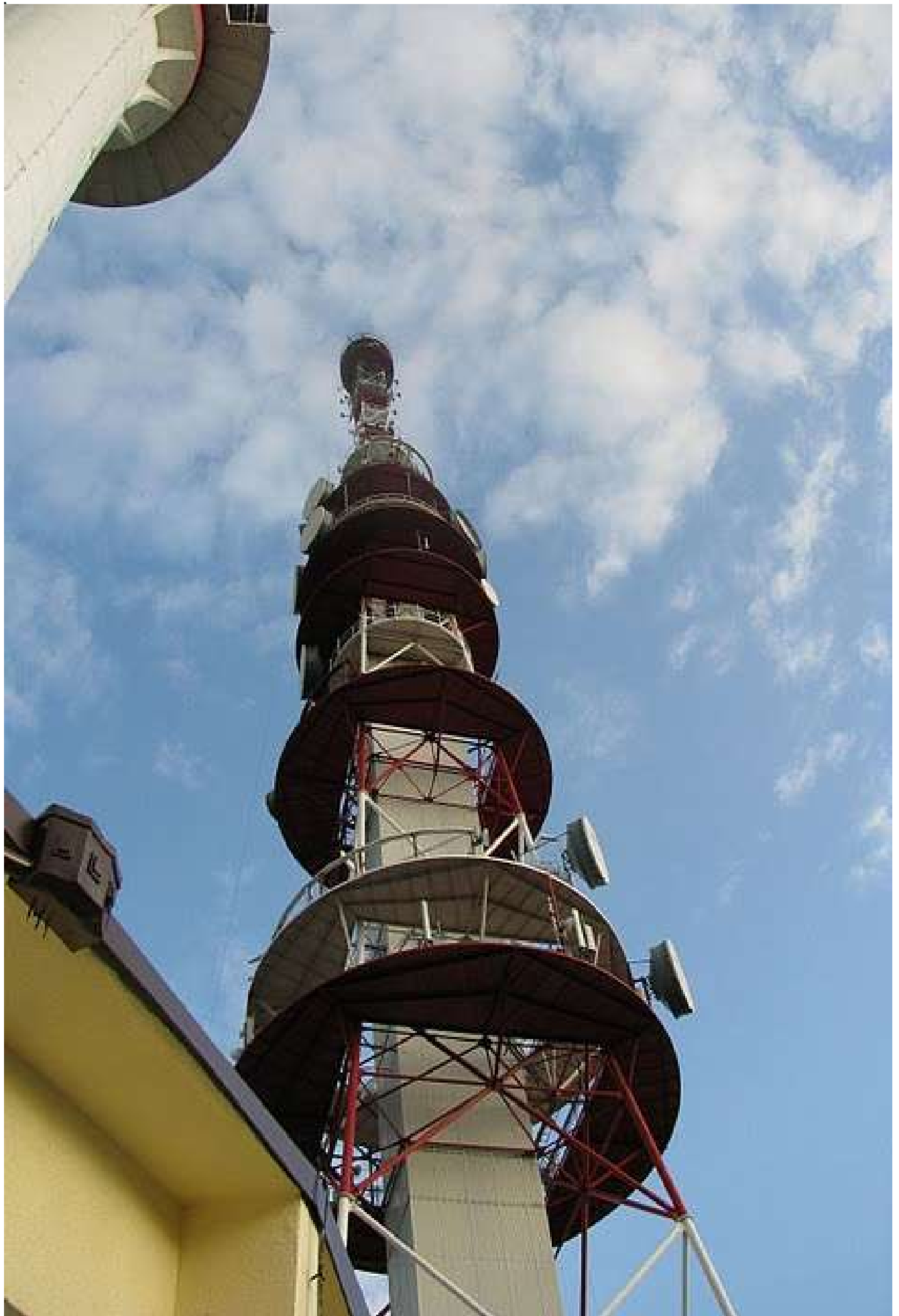
Neue Baken in Poznan, JO82KL im Testbetrieb: SR3CHL, QRG 5760.820MHz (1Watt, gestockter Schlitzstrahler) und SR3LHD, QRG 1296,973MHz (10W out) sowie SR3XHP, QRG 10368.970Mhz (4Watt, Ant: 2x8 Slot 10db, 105m a.s.l. + 110m a.g.l.)
